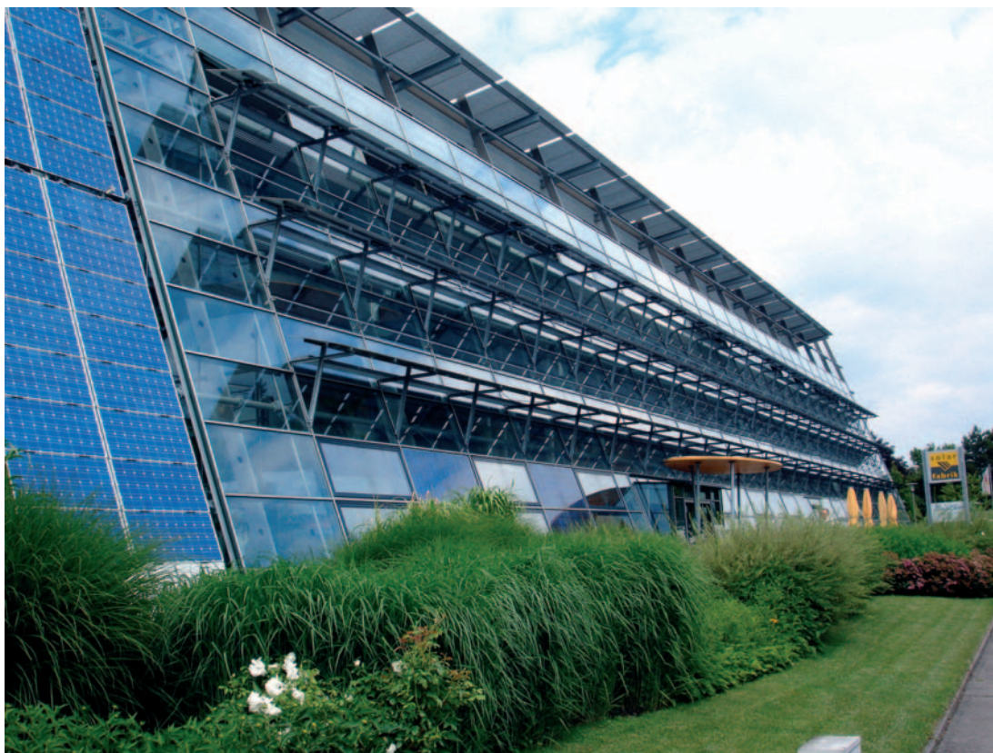
Solar-fabrik - Usine de panneaux photovoltaïques - Freiburg, Allemagne
