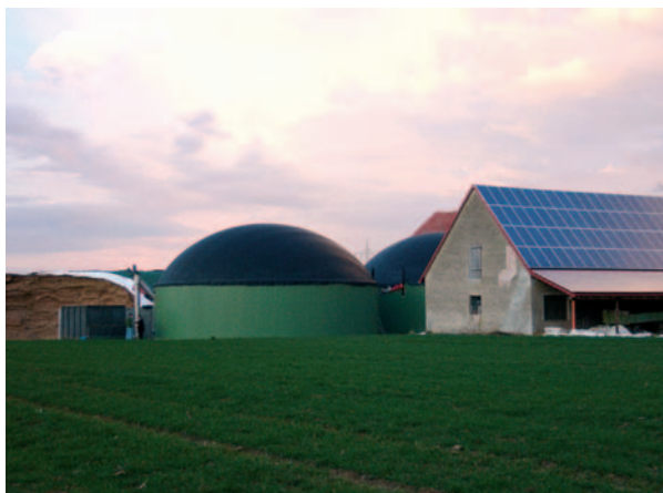
Méthanisation à la ferme, Allemagne
