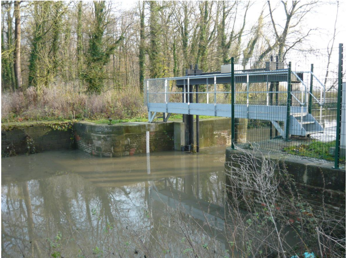
Ecluse du Grand Dam suite aux travaux de 2009 (photo lors de la crue de Décembre 2009)
