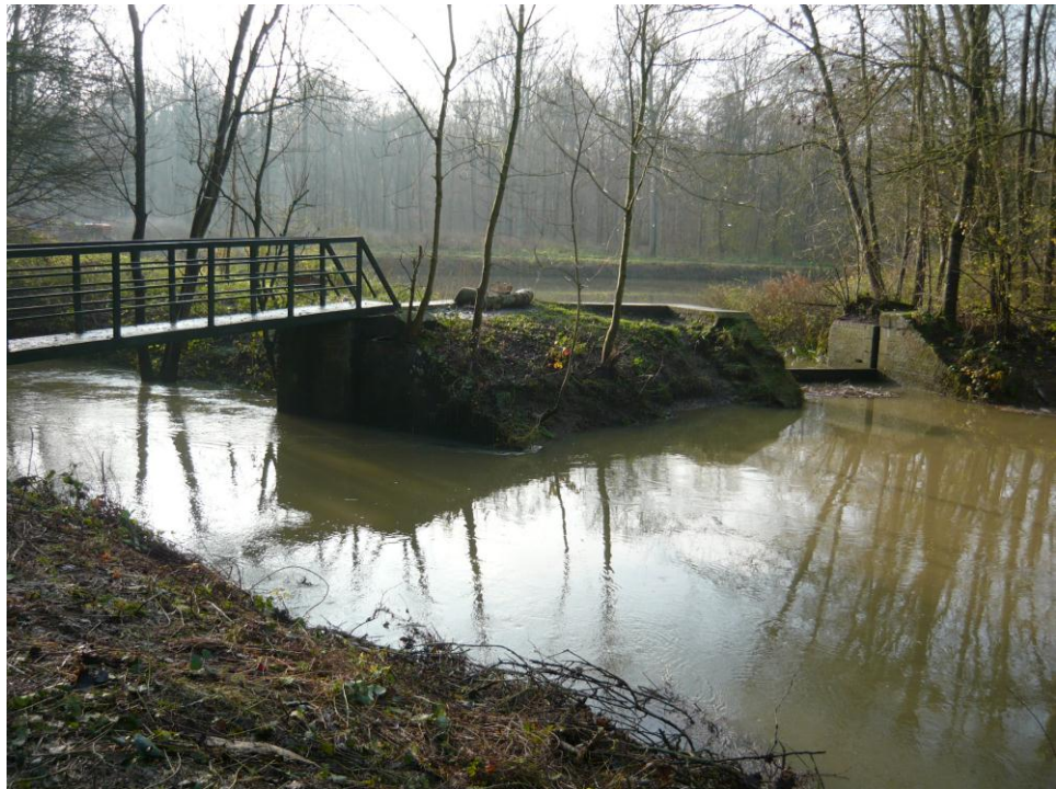
Batardeau entre la Bourre et le canal du Pré à Vin
