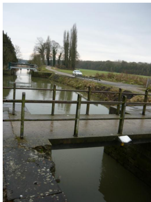
Vue sur l'ancienne écluse et sur l'écluse de Motte aux bois
